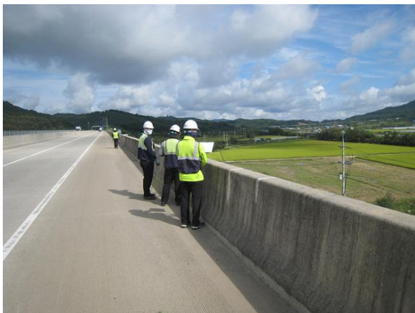
도보를 이용한 근접조사
